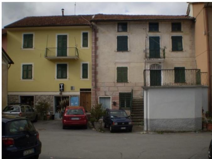
2. **Tipologia a schiera su percorso di versante:** si tratta di aggregazione di elementi modulari funzionalmente autonomi di massimo 3 piani ed aventi in comune il setto murario trasversale di divisione; poiché il percorso distributore risulta inclinato, spesso ci sono sfalsamenti altimetrici tra elementi di schiera contigui e l'accesso può avvenire con scale esterne. Le coperture sono a due falde con colmo parallelo alle facciate principali e all'andamento delle curve di livello.
